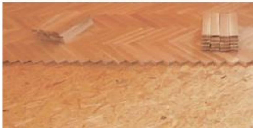
Primjeri izvedbe suhog estriha s drvenovlaknastim pločama
