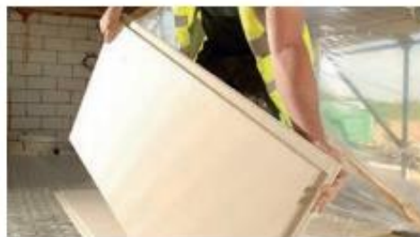
Postavljanje višeslojnih gipsvlaknastih ploča direktno na nosivu konstrukciju
