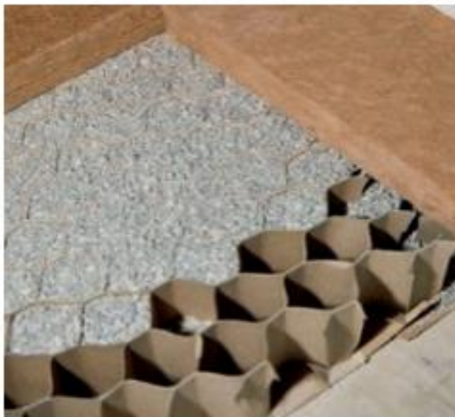
Primjeri moguće izvedbe estriha sa suhim nasipom
