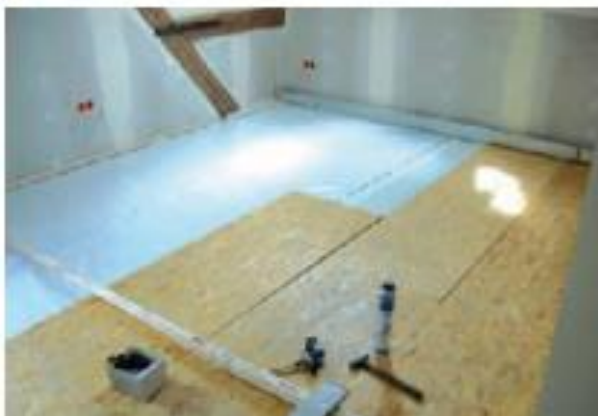
Primjeri izvedbe suhog estriha s drvenovlaknastim pločama
