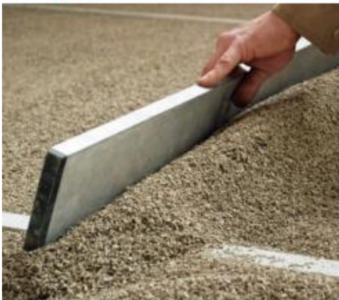
Primjeri moguće izvedbe estriha sa suhim nasipom
