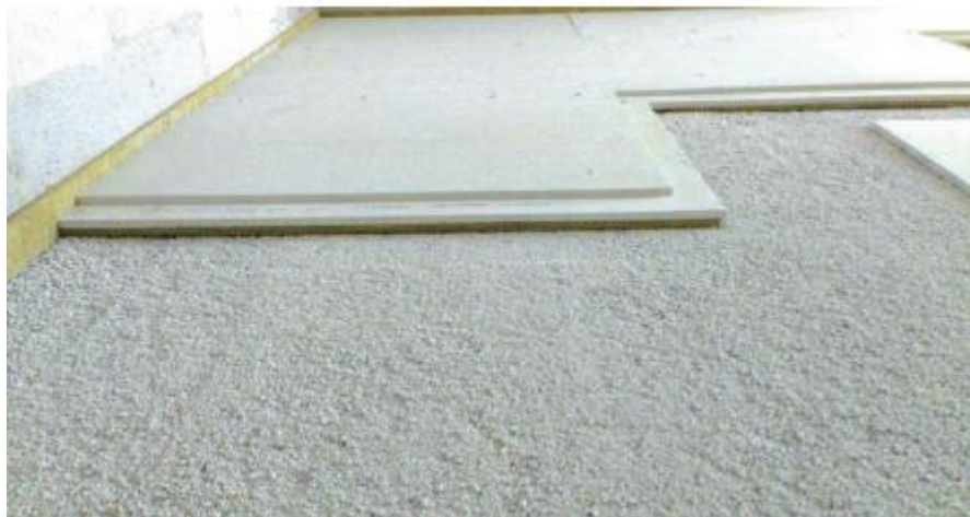
Primjer spoja suhog estriha na nasipu od perlita sa zidom zbog zaštite od udarnog zvuka
