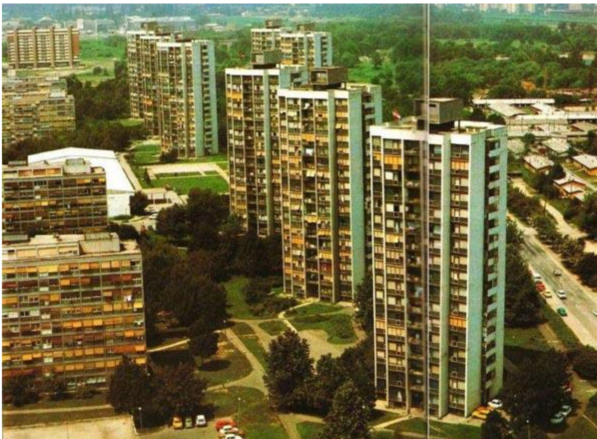
STAMBENI TORNJEVI U ZAPRUĐU - ZAGREB
