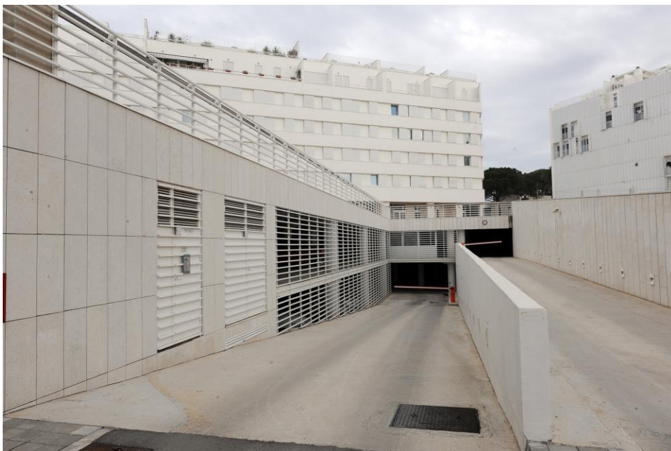
RAMPA ZA ULAZ U GARAŽU ISPOD ZGRADE
