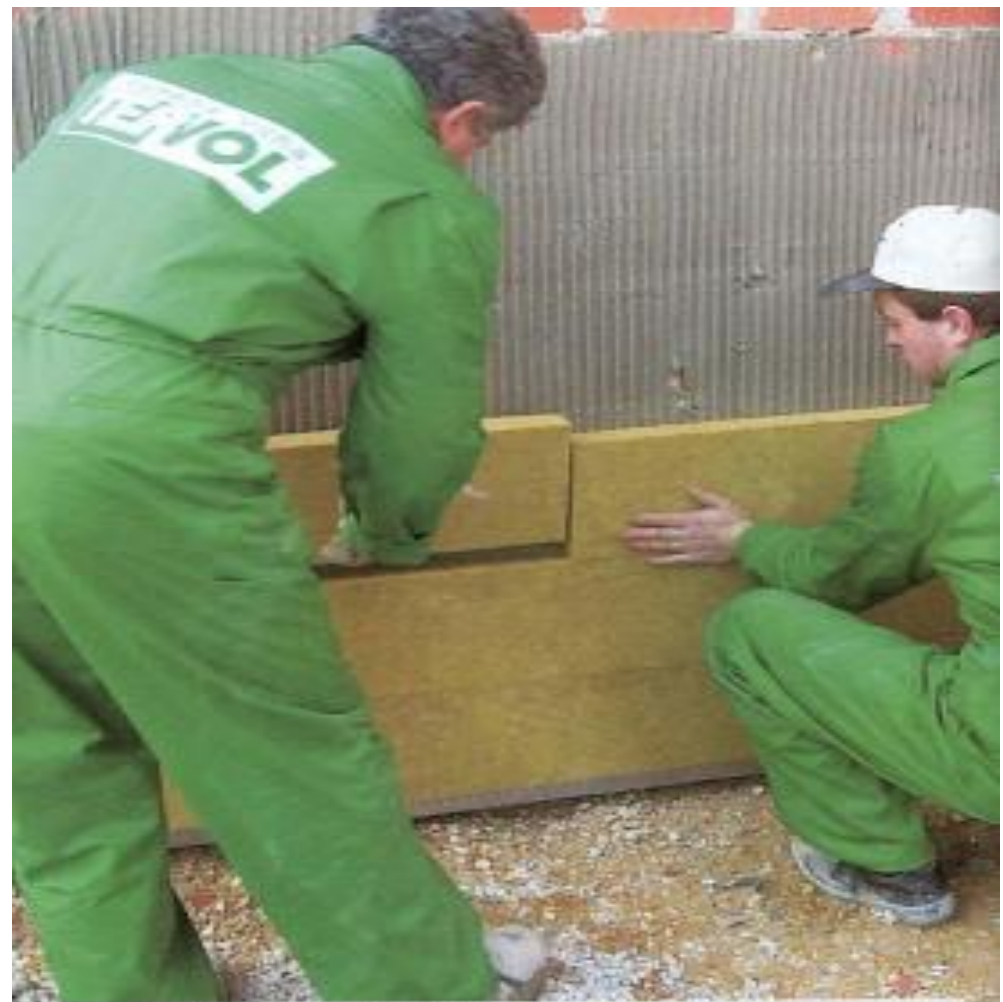
Izolacija kontaktne lamelne fasade - Tervol DP-9 Lam
