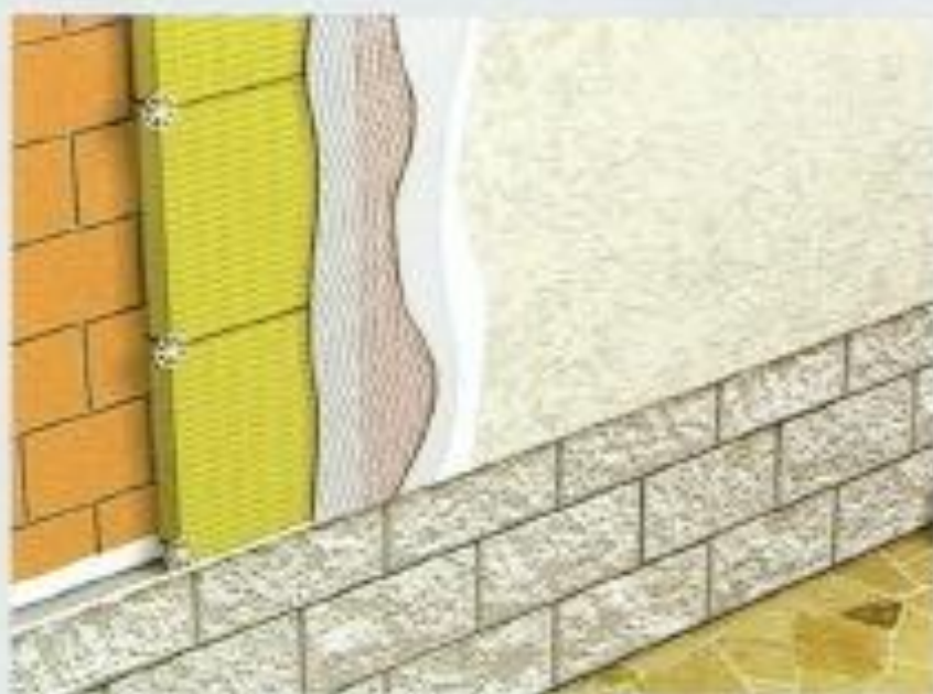
Prikaz svih slojeva izolacije
