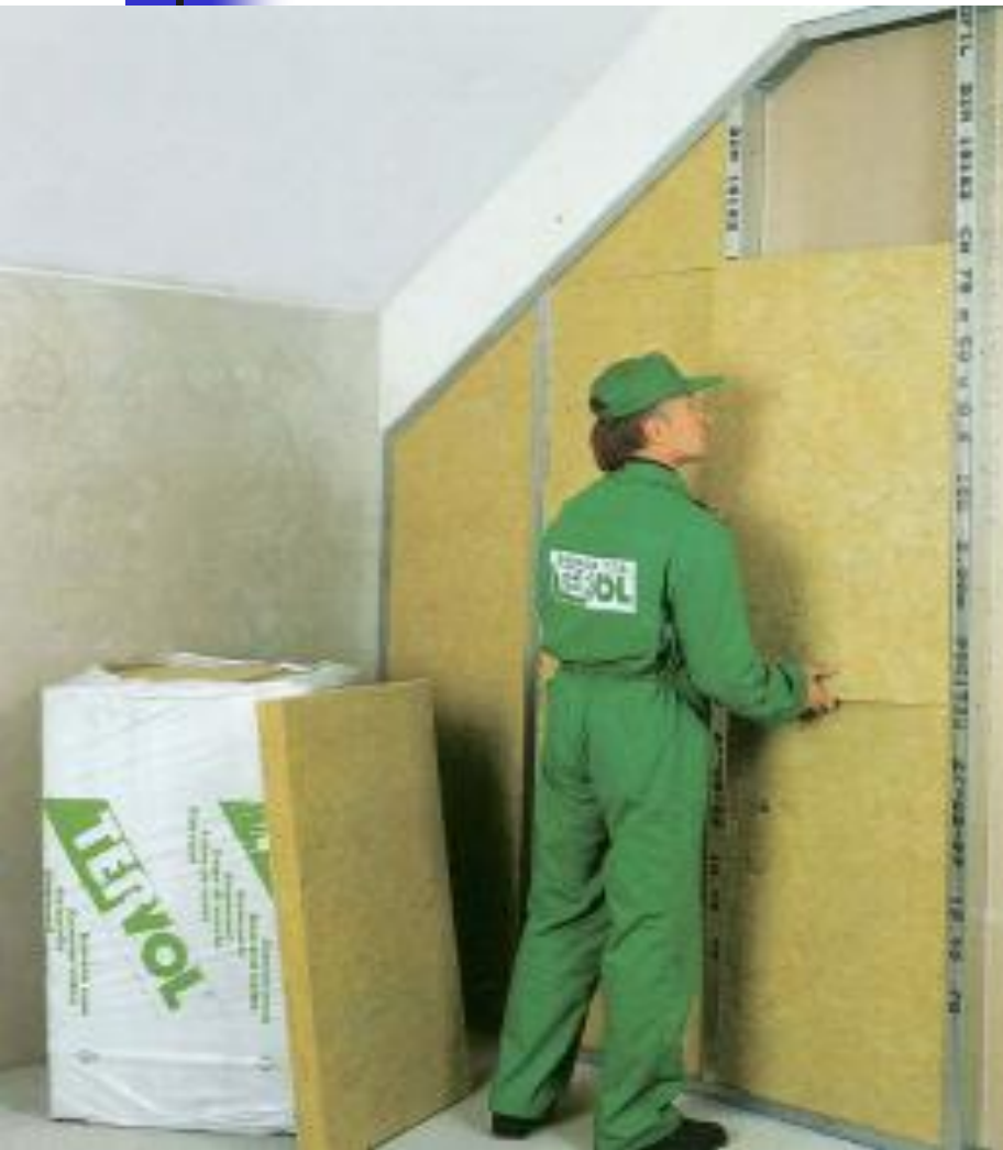
Izolacija kontaktne lamelne fasade - Tervol DP-9 Lam
