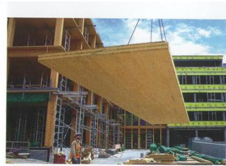
Slika 1-73 Primjer upotrebe križno lameliranih ploča u višestambenoj zgradbi [81]
