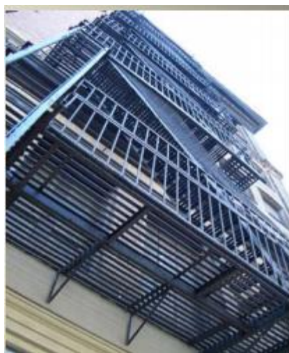
ČELIČNO SPOREDNO STUBIŠTE
