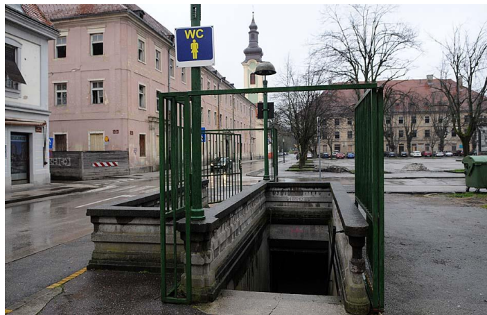
ULAZ U PODZEMNI WC
