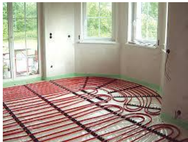
POSTAVA CIJEVI ZA PODNO GRIJANJE
