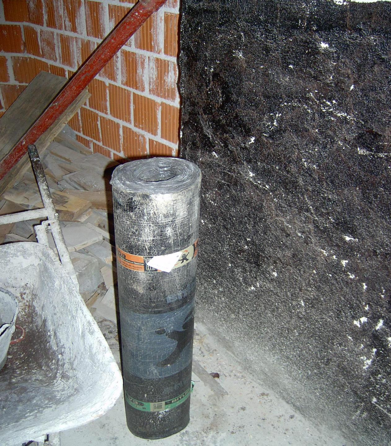
Pri postavljanju hidroizolacije na veću površinu ( pod ili ravni krov), postavljamo ljepenke tako da se preklapaju 10 cm. Međusobno ih lijepimo bitumenom.
