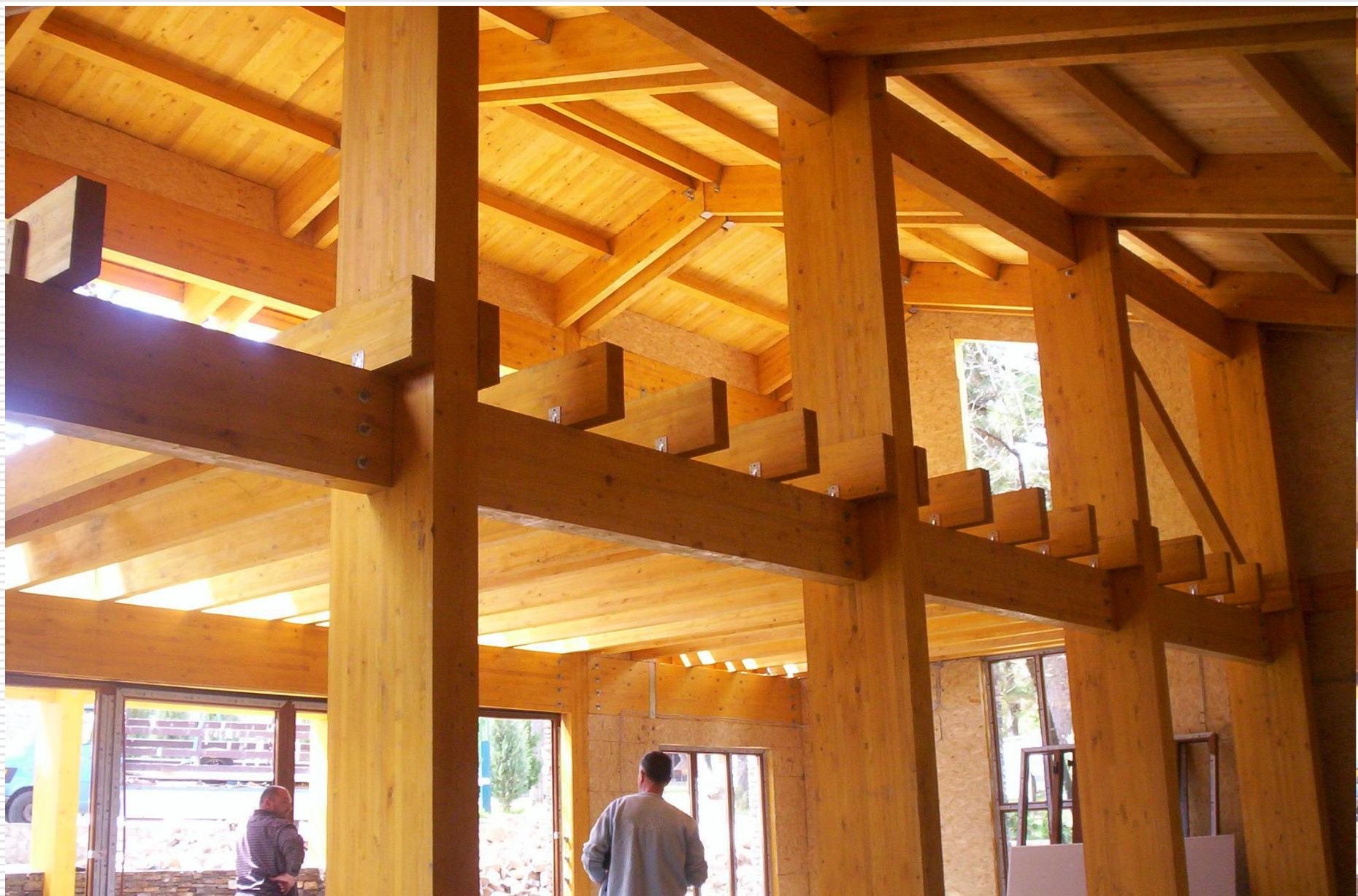
Konstrukcija od lameliranog drva
